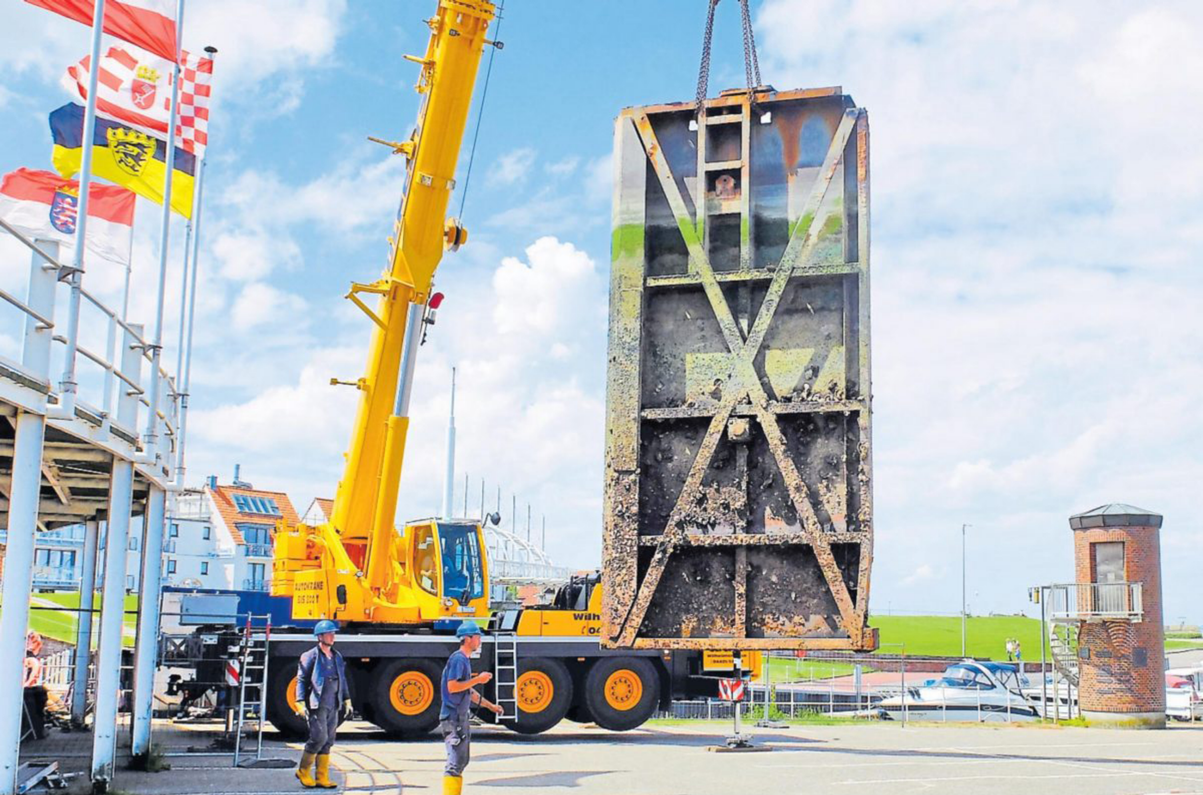
Das erste der beiden alten Torflügel des Sielwerks Bensorsiel, Siellauf Ost, wurde mit dem Kran der Firma Ulferts ausgehoben und auf einen Tieflader verladen sowie von Mitarbeitern der Voß Werft zum Verschrotten abtransportiert. BILD: JOHANN MEINEN
